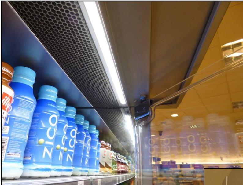
*Les armoires originales comprennent l'éclairage traditionnel de tube & stores de nuit.*
