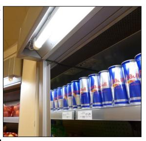
Le modifiche includono la rimozione delle lampade di illuminazione baldacchino normali e introduzione di strisce a LED integrate. Un sistema di sicurezza di idrocarburi è stata montata.
