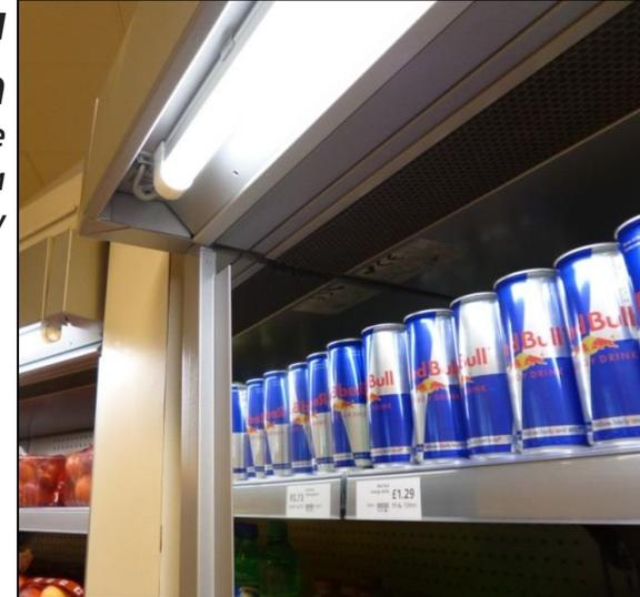
Модификации включают удаление стандартных ламп для навеса & подключение интегрированных полос светодиодного освещения.
